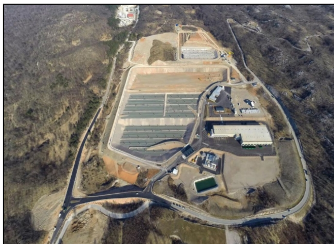
Slika 9. Postrojenje mehaničko biološke obrade u ŽCGO Marišćina (izvor: http://www.ekoplus.hr )
